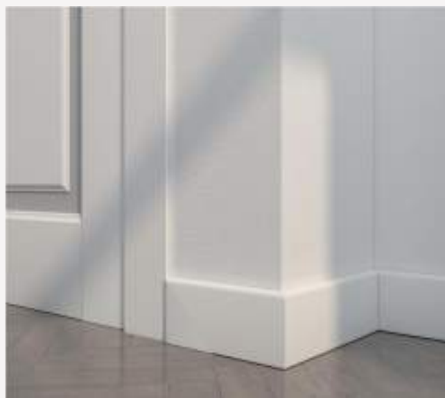
Стыки на внешних и внутренних углах оформляются посредством зарезки плинтусов под 45°.
