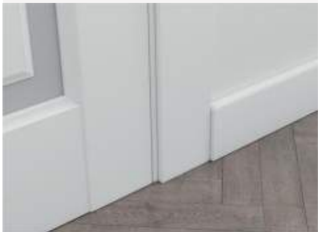
Зарезка «в стену»
